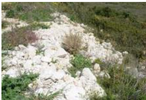
Figure 54 : Remblais issus du chantier de construction (Source : M. ERASO, Ecotonia)
